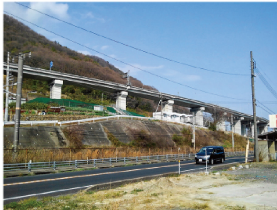
▲国道2号線 木原道路開通
